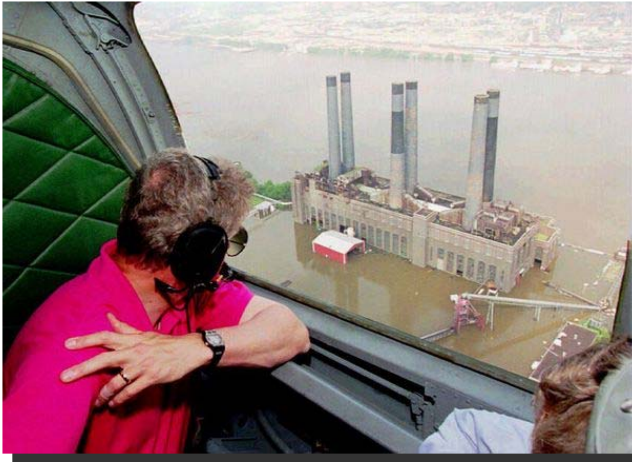
1993: el presidente de los EEUU Bill Clinton sobrevuela una central térmica inundada por el desbordamiento de los ríos Missouri y Mississippi
