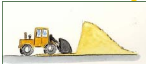
Carga de los camiones con pala cargadora.
