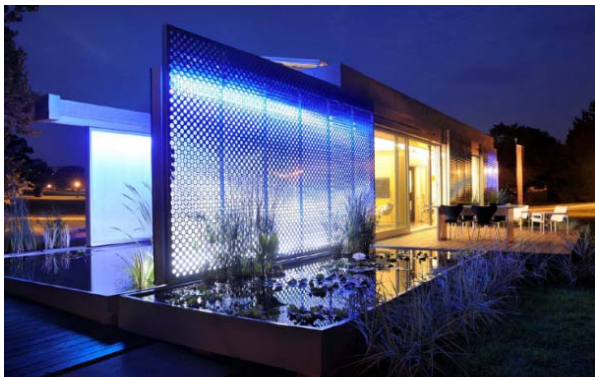
Sistema móvil de protección solar. Permite o impide la penetración de radiación solar en función de condiciones climáticas exteriores y consignas interiores
