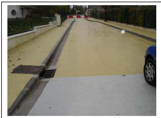
Figura 2. Estado de la superficie de rodadura, tras percolación de la lechada, antes (izda.) y después del granallado (dcha.)
