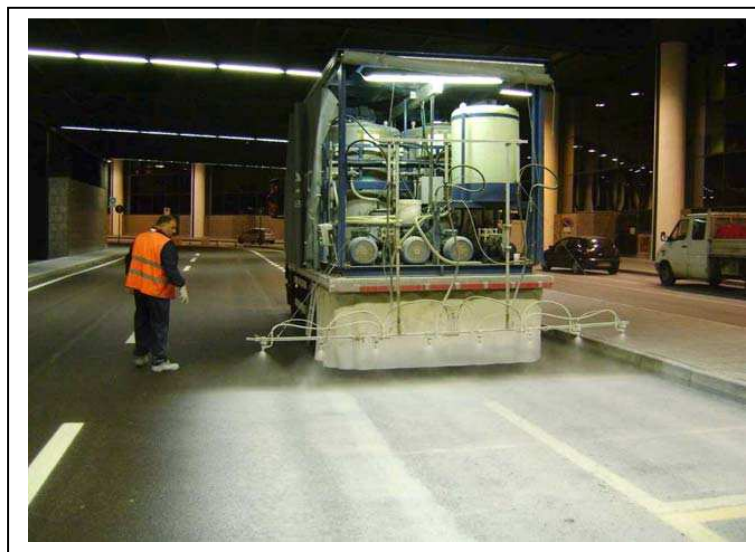
Figura 3. Ejecución de técnica de pulverización sobre rodadura existente
