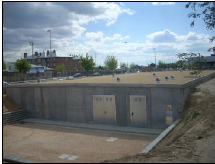
Figura 2. Depósito de agua regenerada semienterrado.
