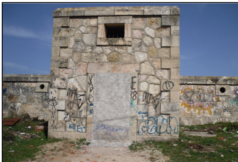
Figura 7. Depósito de agua potable en desuso, reutilizado como depósito de agua regenerada en San Agustín de Guadalix (Madrid).
