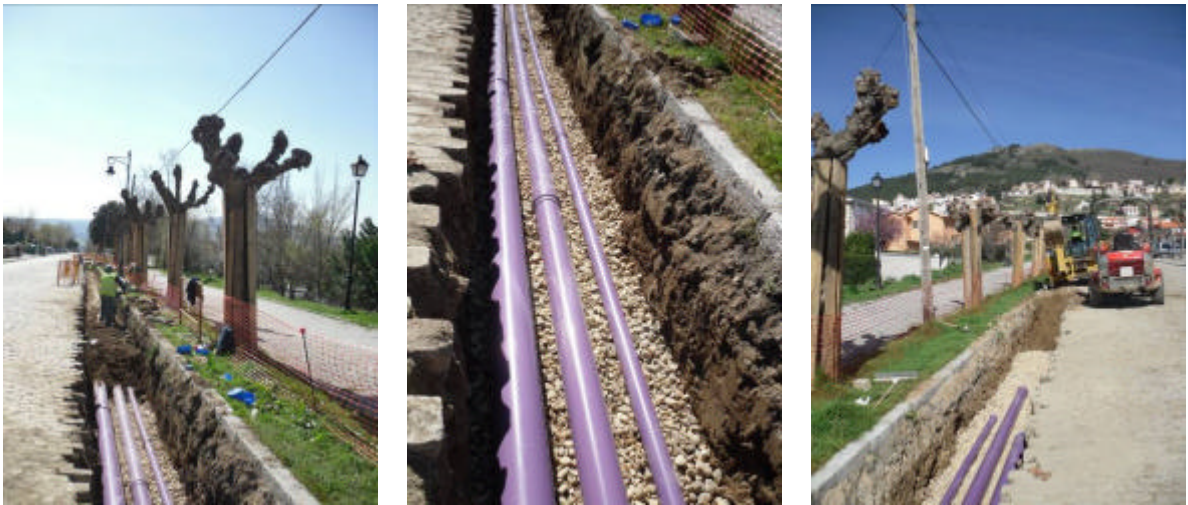
Figura 8. Ejecución de las obras de la red de riego con agua regenerada dentro del núcleo de Miraflores de la Sierra (Madrid).
